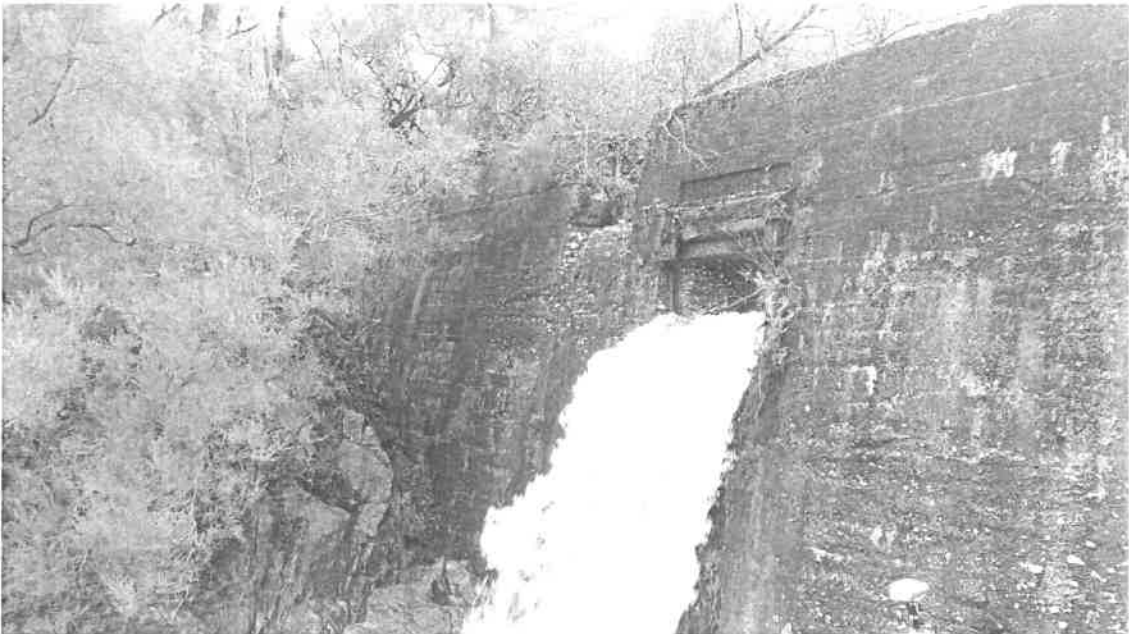
Vistas da presa dende augas abaixo.
