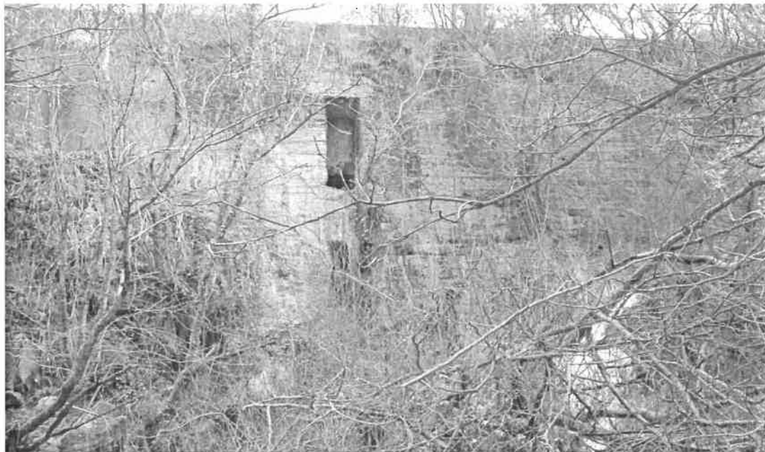
Vistas da presa dende augas abaixo.
