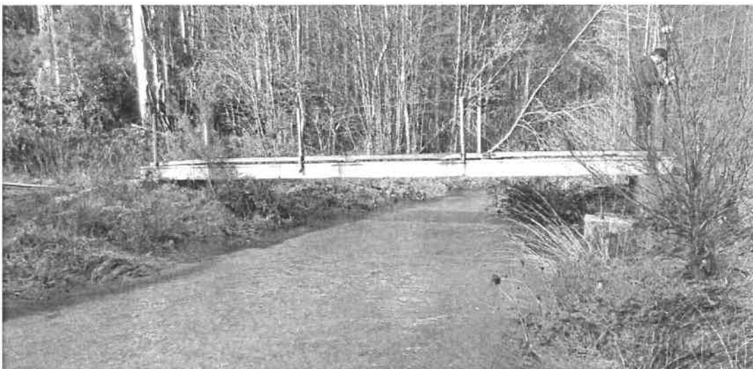
Pasarela existente nesta zona.
